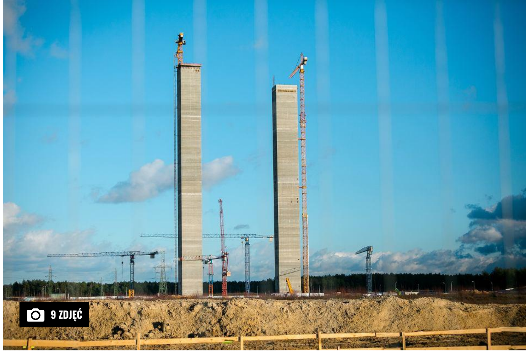
Elektrownia Ostrołęka. Budowa bloku C stanęła, pozostały dwie 'wieże Kaczyńskiego' (Jarosław Sender / Jarosław Sender/East News)
